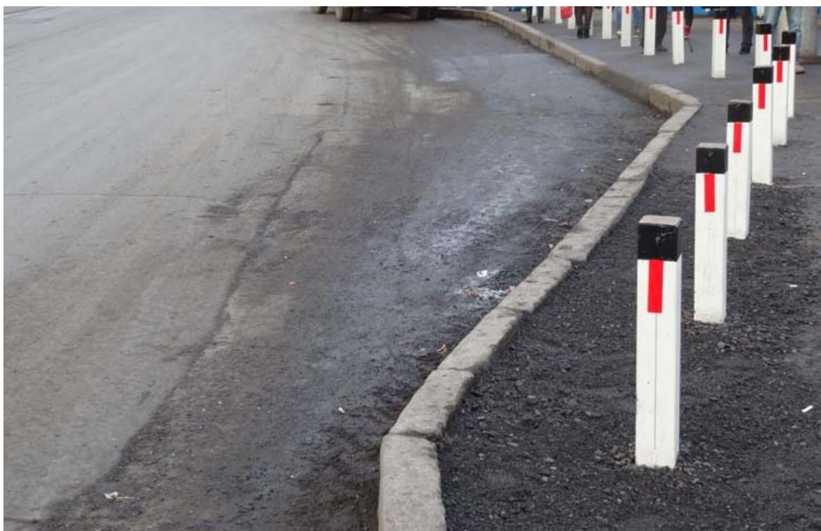
Рисунок 3.37 – Пример обустройства остановочного пункта ограждающими устройствами
